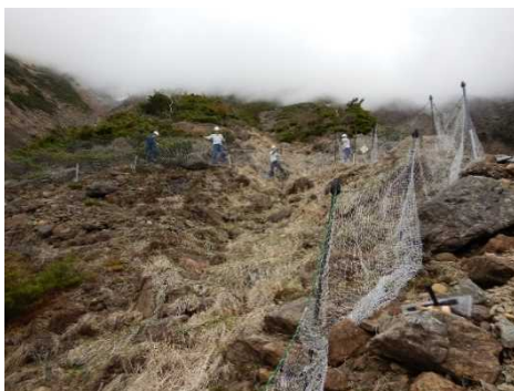
早池峰山国有林に ニホンジカ対策の 植生保護柵を設置
