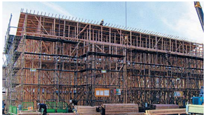
東北森林管理局手形第2木造宿舍 (構造材：秋田杉を主体としたスギ集成材)
