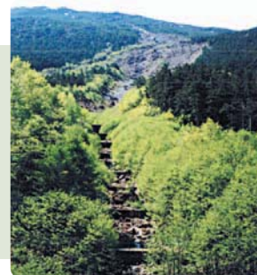
治山工事により復旧した状況
