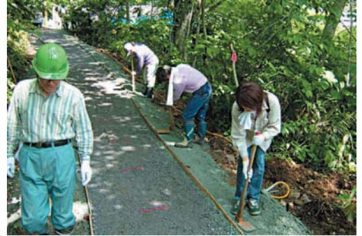
ボランティアによるバリアフリー歩道の整備 青森県中津軽郡西目屋村
