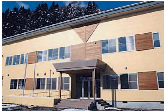
岩手北部森林管理署木造庁舎 (構造材の約半数をアカマツ材使用)
