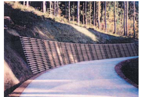
木製校倉式土留工 (秋田県湯沢市)
