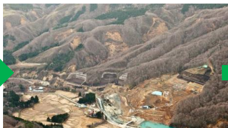
復旧工事施工中
