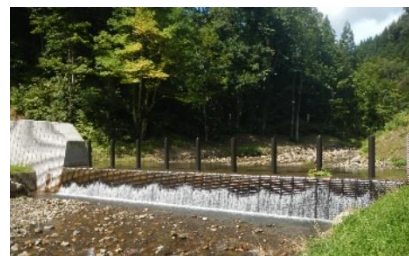
【治山ダム（北秋田市）】
