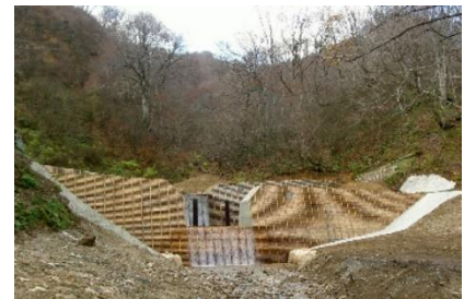
【治山ダム（酒田市）】
