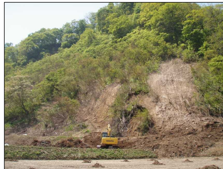
融雪による山腹崩壊状況 （下流の田んぼに流出した土砂撤去作業）
