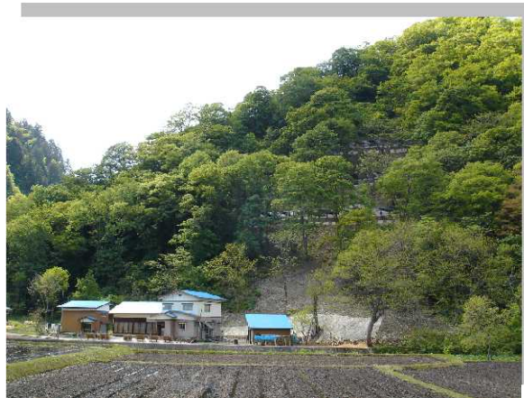
なだれ防災林造成(なだれ予防柵の設置)
