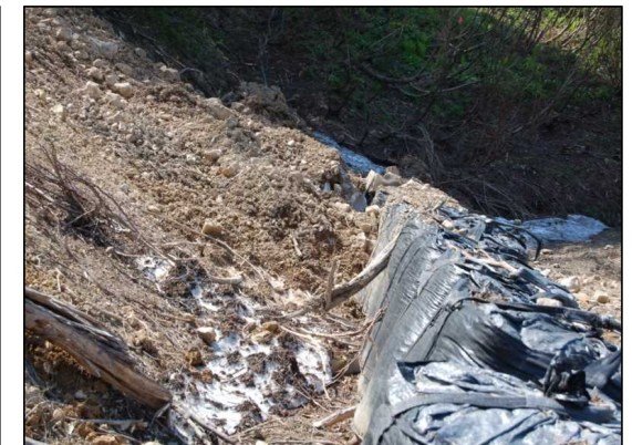
大型土のうの融雪期崩落土砂捕捉状況 (27.5月)
