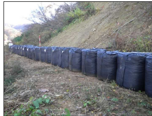
本施工前の応急対応大型土のう積工 (26.10月)
