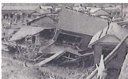
宮古橋下流付近向町の惨状
