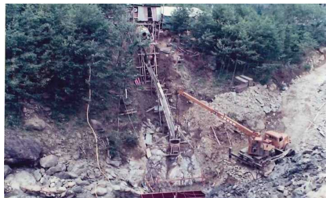
S 4 9 の 石 合 沢 治 山 工 事
