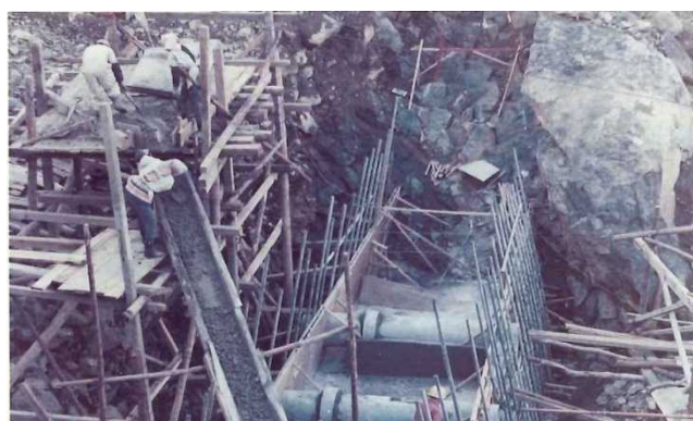
S 4 8 の 石 合 沢 治 山 工 事
