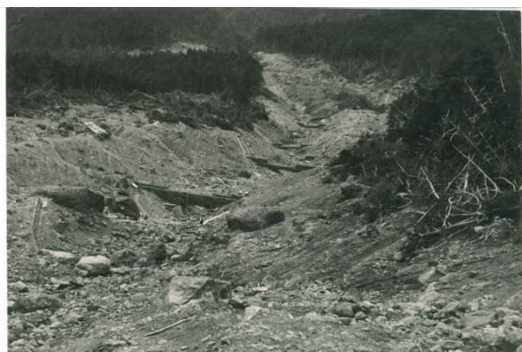
S 3 2 頃 の 握 沢 練 詰 石 堰 堤
