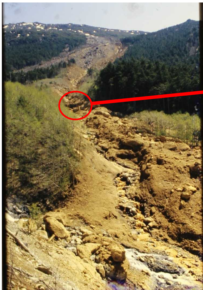
昭和55年5月の台風災害直後の荒廃状況写真
