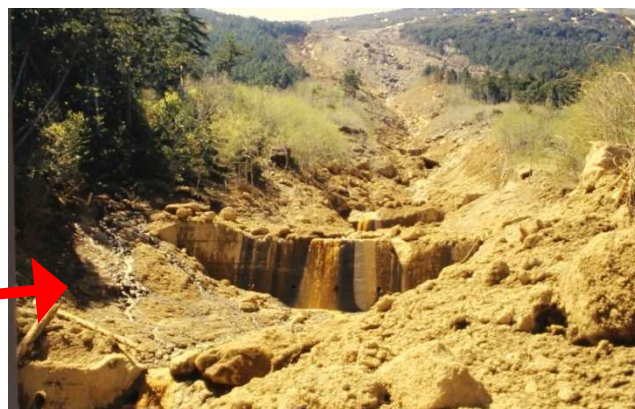
堤体は破壊されたものの土石の流出を食い止めた様子がわかります。
