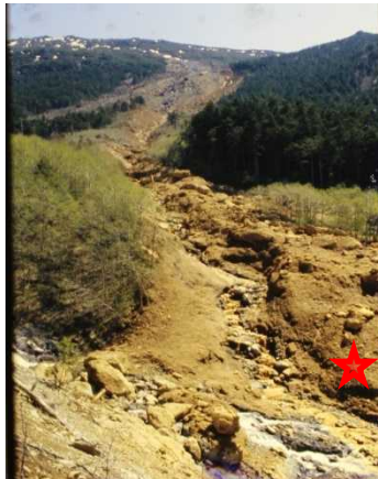
昭和55年台風災害直後 それまでに施工した施設 が被災。
