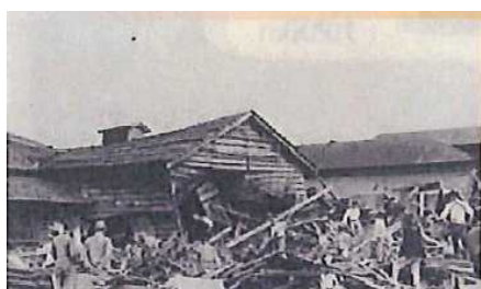
水産製造場倒壊の状況
