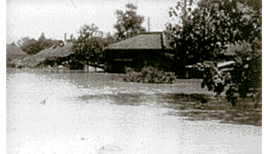
～ 決壊した堤防付近～
