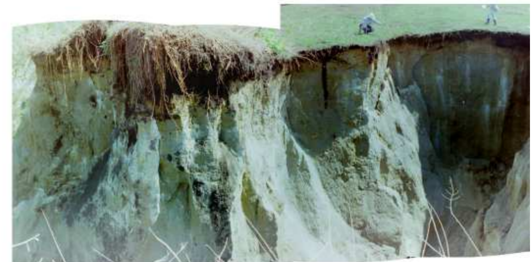
写真 ⑯ 滑落帯延長上に発生した崩壊（シラス）
