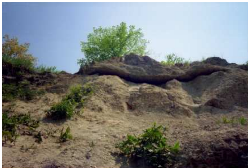
写真 ③ すべり面上にせり出す移動土塊
