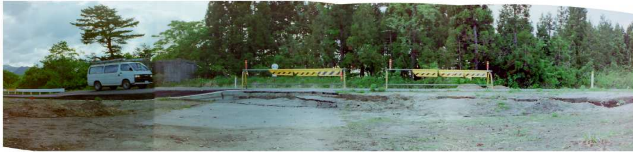
写真 ⑱ 国道 458 号沿いに発生した陥没帯下流壁（写真奥が斜面下方）
