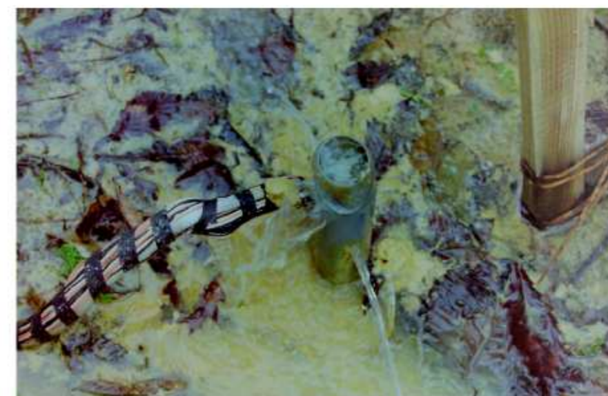
写真 ⑩ 既設ボーリング孔の自噴
