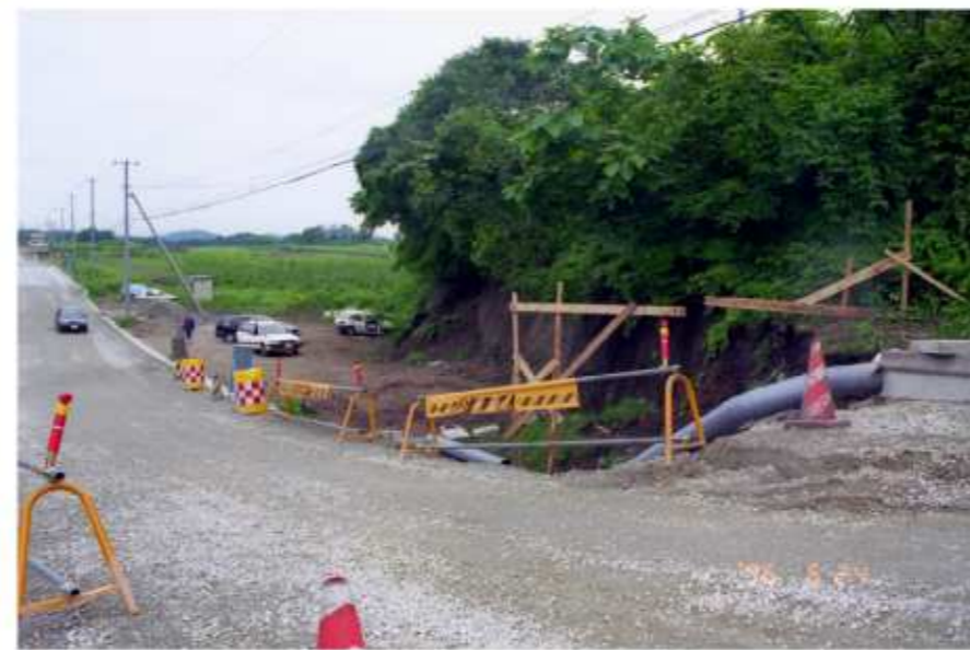
写真 21 陥没帯の上流壁（写真左手が斜面下方）
