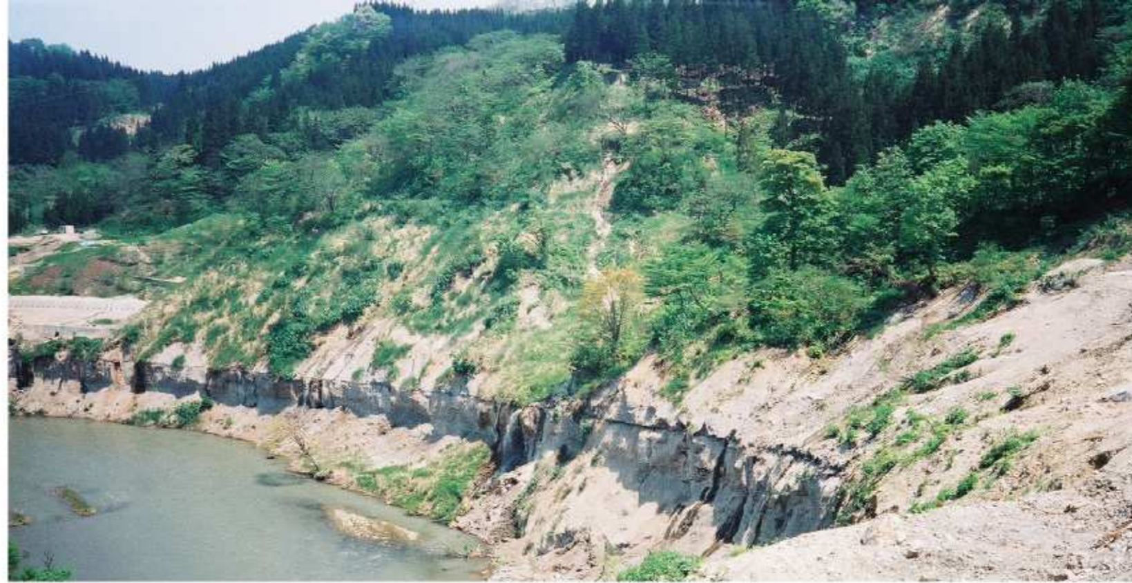
写真① 地すべり末端状況（遷急線付近がすべり面）
