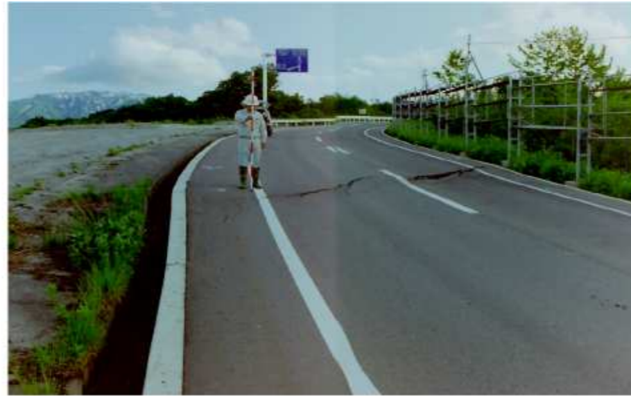
写真 ⑬ ブロック右側壁中腹部の国道 458 号に発生した亀裂
