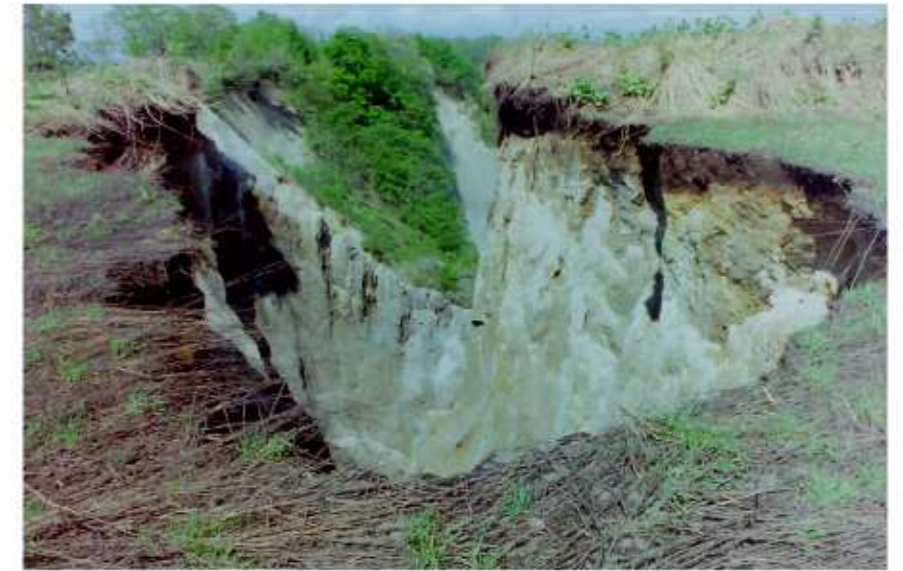
写真 ⑮ 滑落帯延長上に発生した崩壊（シラス）
