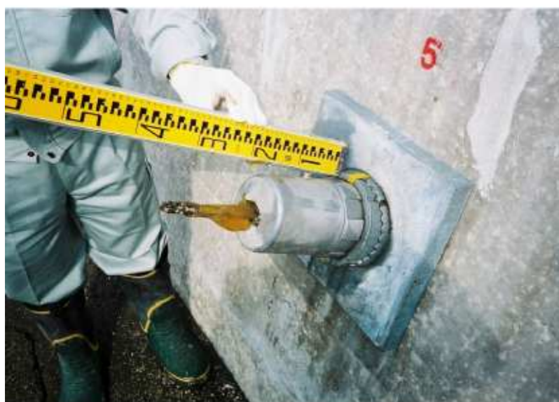
写真 ⑤ 地すべり末端部で破壊されたアンカー tendon
