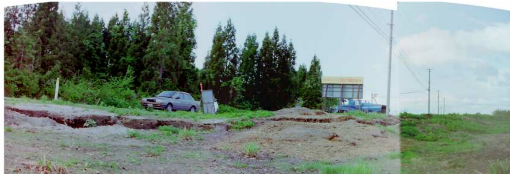
写真 ⑲ 国道 458 号沿いに発生した陥没帯（写真奥が斜面下方）
