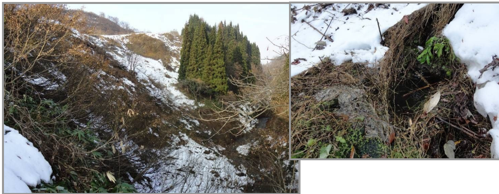
写真 5.8 シラス急崖脚部の湧水
