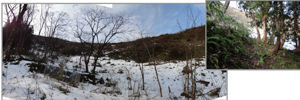
写真 5.2 II-1ブロック斜面上部の状況と 線緩線付近での小規模なすべり
