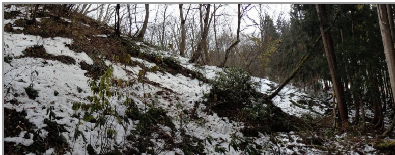
写真 5.12 急崖部にみられる浅層崩壊
