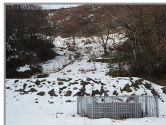
写真 5.3 水路工と集水井工
