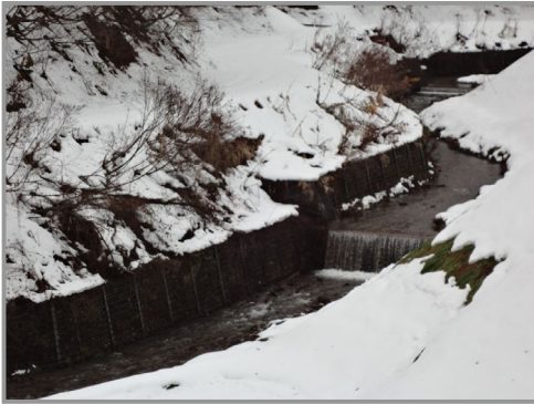
写真 5.20 古水川の護岸工と谷止工による浸食防止
