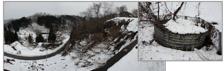
写真 5.11 Ⅵ（蕨郷橋）ブロック頭部と集水井
