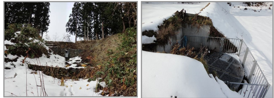
写真 5.5 水路工と土留工による山腹工と集水井工
