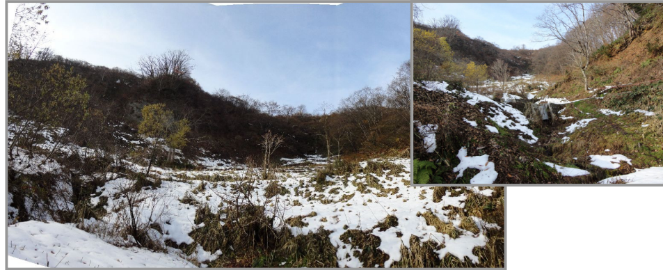
写真 5.1 Iブロック斜面上部の状況と斜面下部の対策工（水路工，土留工）
