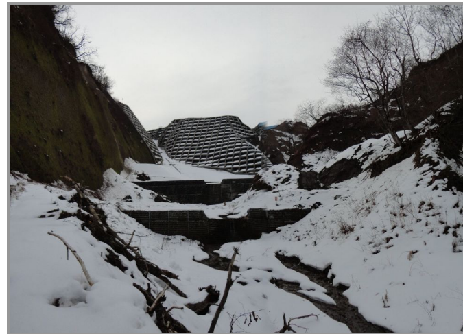
写真 5.15 アンカー付き法砕工と谷止工
