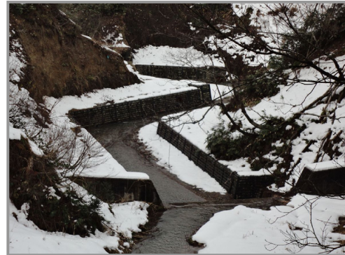
写真 5.20 古水川の護岸工と谷止工による浸食防止
