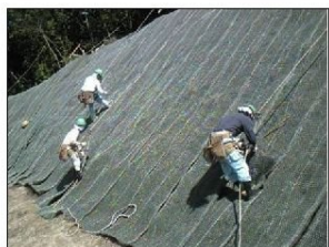
■無種子マットの敷設
