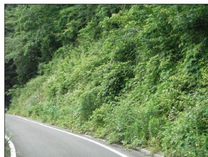
施工後4年3ヶ月の状況
