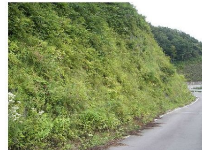
施工後3年10ヶ月の状況
