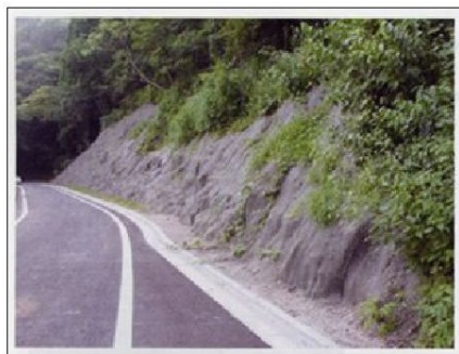
施工後1年3ヶ月の状況
