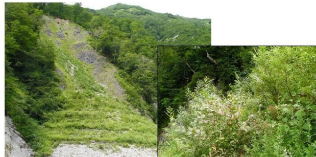
施工後4年9ヶ月の状況
