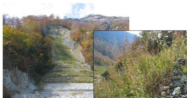
施工後2年の状況
