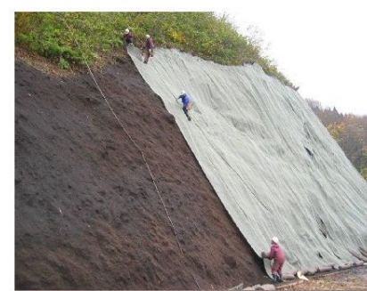
施工時の状況
