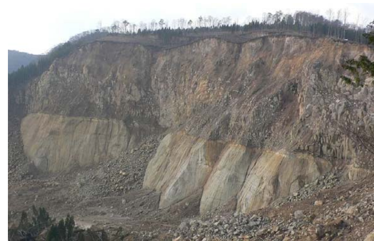
図 3.1.13 拡大亀裂下部の滑落崖 (H.21.11.25 撮影)
