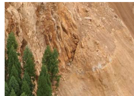
図 3.1.28 拡大亀裂右岸側下部の滑落崖 (H.20.8.5 撮影)
