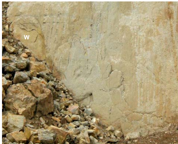
図 3.1.23 拡大亀裂下部の滑落崖の中央付近 (H.21.9.1 撮影)
