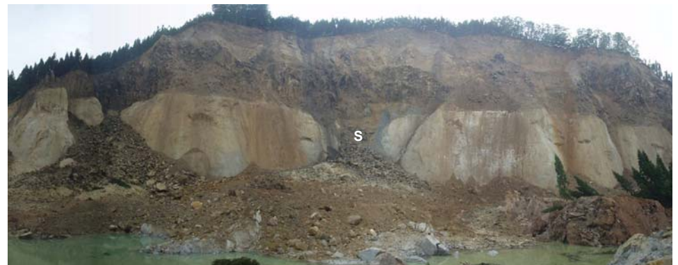
図 3.1.17 拡大亀裂下部の滑落崖 (H.20.8.6 撮影)
