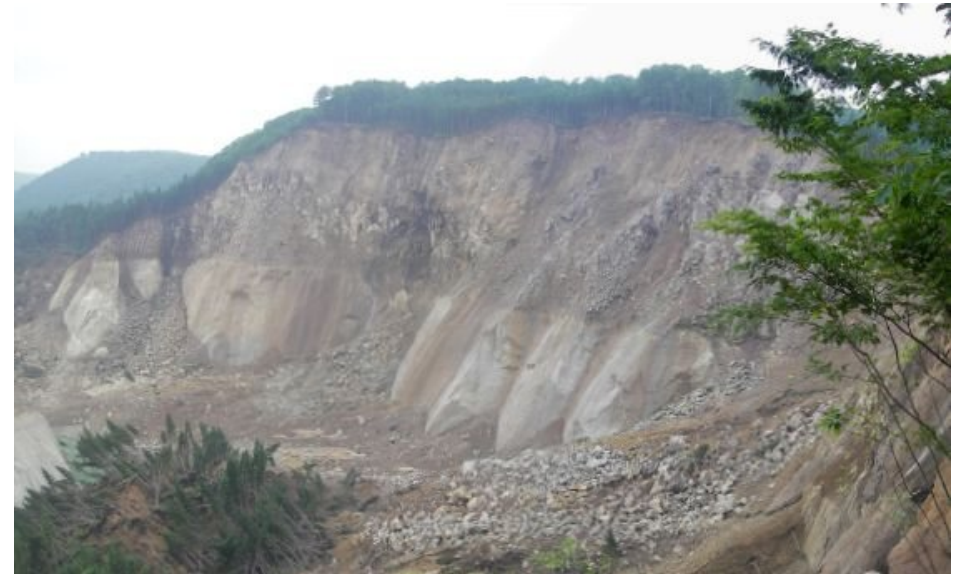
図 3.1.12 拡大亀裂下部の滑落崖 (H.20.8.2 撮影)
