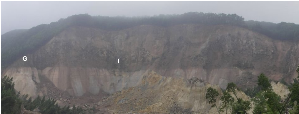
図 3.1.15 拡大亀裂下部の滑落崖 (H.20.7.4 撮影)
