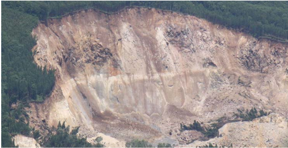
図 3.1.14 拡大亀裂下部の滑落崖 (H.20.6.18 撮影)
