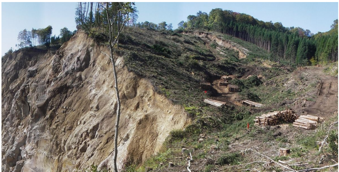
図 3.1.2 H.21.10.16 時点の拡大亀裂の状況 流木が伐採され、応急排土工の準備が進められている
