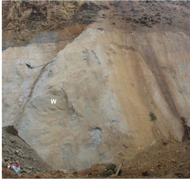
図 3.1.22 拡大亀裂下部の滑落崖の中央付近 (H.20.7.14 撮影)
