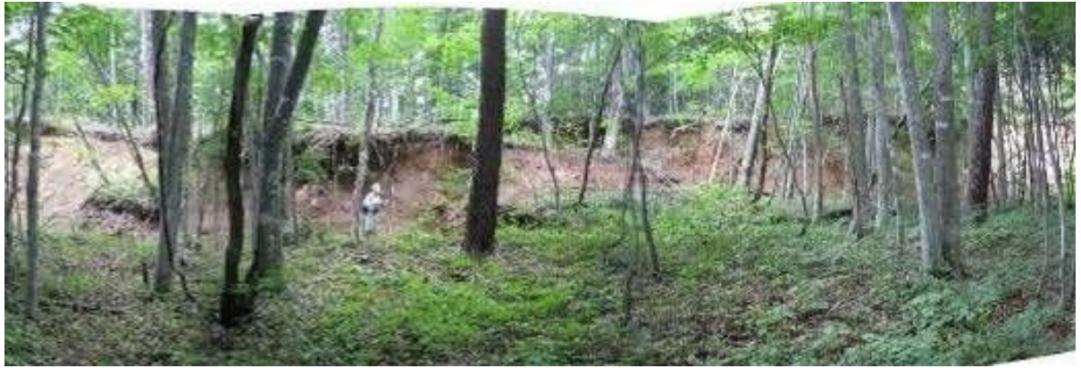
図 3.2.3 滑落崖の現在の状況 (H.21.9)
