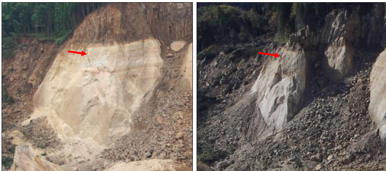
図 3.1.36 滑落崖右側の亀裂の状況 (左 : 2008 年 6 月 23 日 右 : 2009 年 10 月 15 日)
