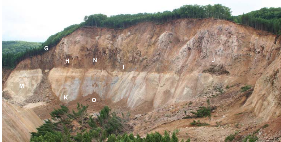
図 3.1.10 拡大亀裂下部の滑落崖 (H.20.6.23 撮影)
