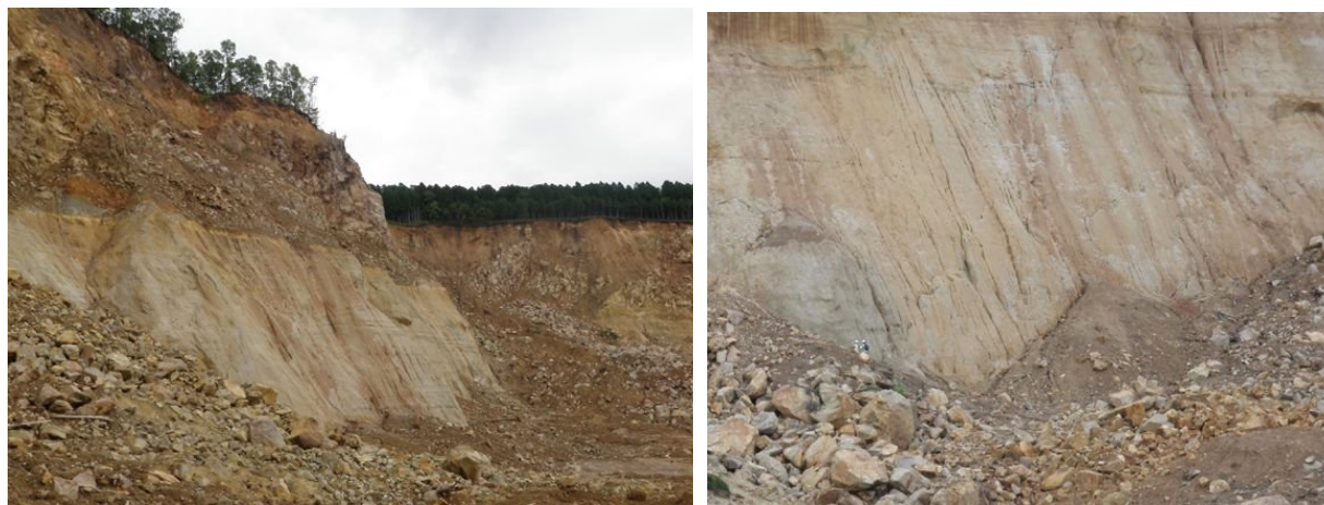
図 3.2.6 主滑落崖の軽石凝灰岩の傾斜 (左) と開口亀裂 (右)
