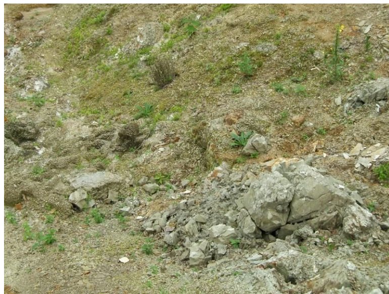
中腹部左側壁付近、風化深度は浅く、脆い表層が少しずつ面的に流出している
