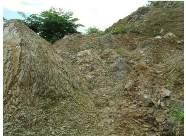
斜面と節理面が直行に近い場合、締まっている場合と、吸水膨張により深部まで脆くなっている場合がある。
