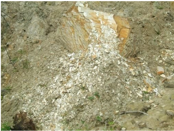
斜面と節理面が平行に近い場合、薄くはがれた岩片が風化により岩屑となり堆積する
