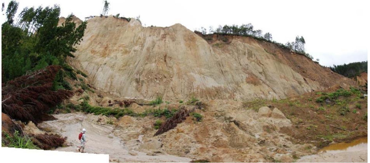
第2リッジ南面における軽石凝灰岩の侵食状況、流出した侵食土砂が平場や窪地に堆積している。
