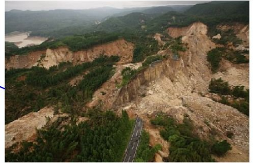
寸断された市道荒砥沢線
