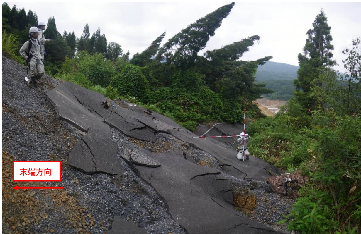
写真 1. 4. 2 道路路面の傾倒
