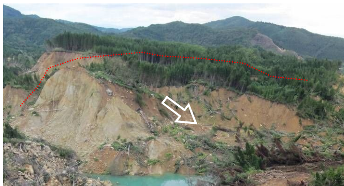
写真2.1.5 第三陥没帯右岸側の残存土塊
