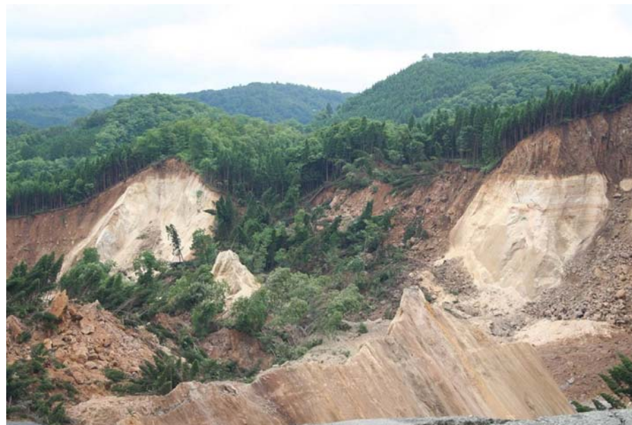
④ 旧地すべりの陥没帯
