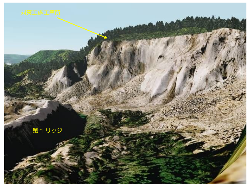
図 2.3.7 ⑥左側壁冠頭部より
