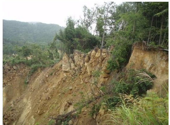
写真 2.1.2 縦のクラックが発達する軽石凝灰岩
