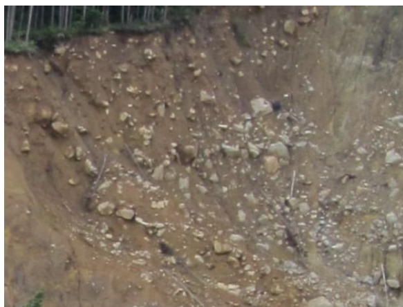
写真2.1.3 侵食により斜面から浮き出した石
