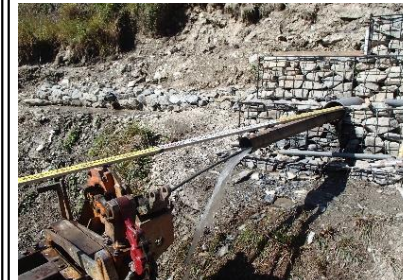
上段：作業状況 (ICT施工) 下段：集水ポーリング
