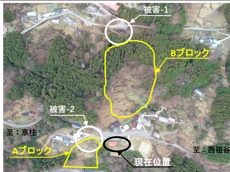
平成30年7月豪雨により被災
