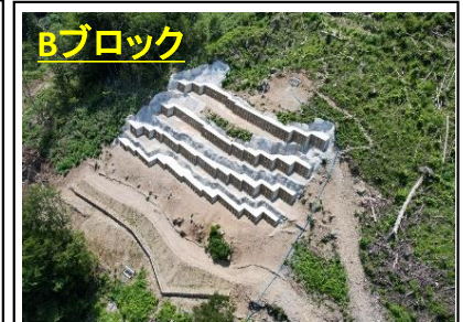
令和3年度に対策工事完了 対策工：アンカー工54本
