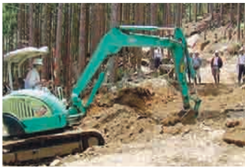
バックホーの操作実技
