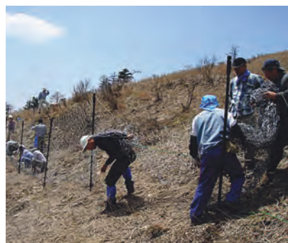
ボランティアによる防護柵の設置
