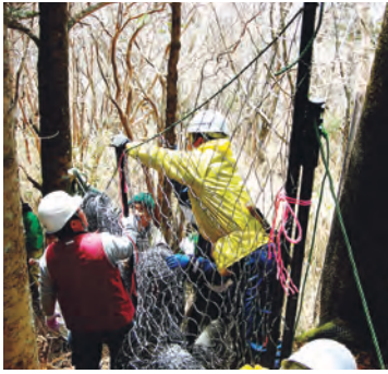
防護柵の設置
