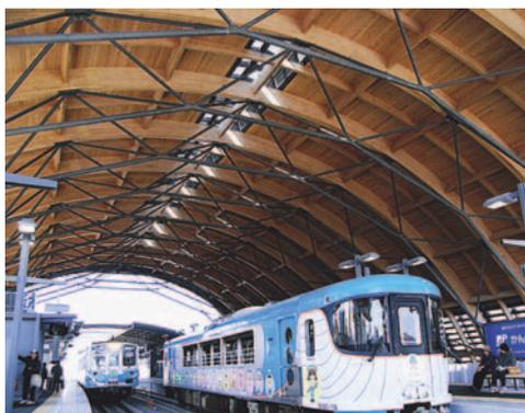
二月、新駅舎の建築を進めていたJR高知駅に、駅舎を覆うアーチ状の大屋根が完成し、陸の玄関口のシンボルとして注目を集めています。「くじらドーム」と名付けられたこの大屋根は、長さ約八〇m、幅約三八m、高さ約二三mで、梁や天井に高知県産のスギをふんだんに使用して、高知を訪れた方々に「地産地消」と「森林県高知を多にPRしています。
