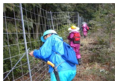
シカ防護柵点検補修
