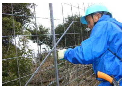
シカ防護柵点検補修
