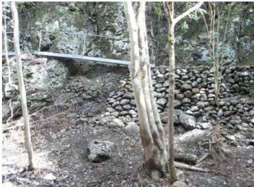
遊歩道修繕完了
