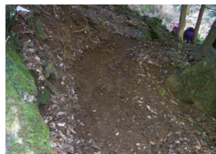
登山道修繕完了
