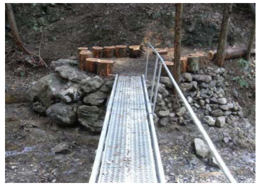
遊歩道修繕完了
