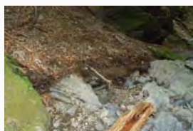
土砂の流出が続くフスベヨリ谷 山腹から降り降りた土砂が大水の度に流されている(2010年5月30日)
