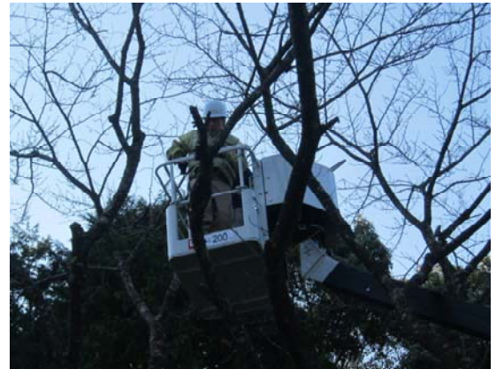
高所作業車による枯枝切除
