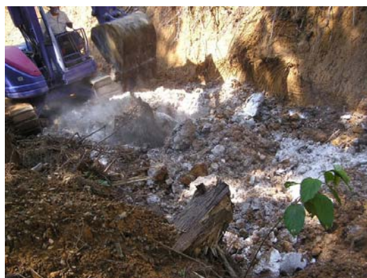
写真 4 生石灰施工状況
