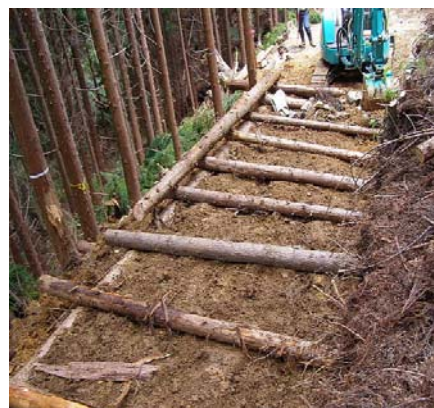
写真 5 路面処理工施工状況
