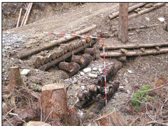
写真 1 2号線の木製谷渡工
