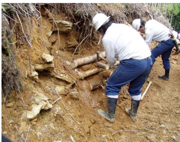
写真2 土留工(施工中)
