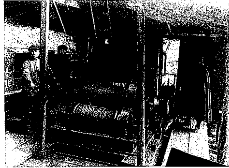
▲集材機運転状況（「事業参考写真帖」より）
