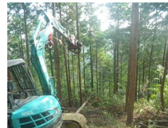
試験地での集材状況
