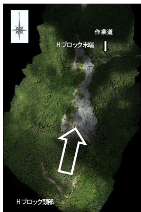
写真1 ドローンによるオルソ画像
