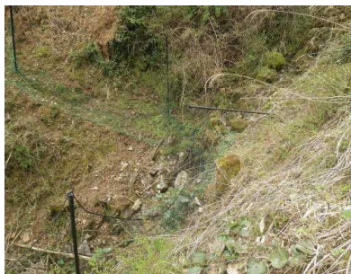
落石・流木で傾いた支柱(↑)
