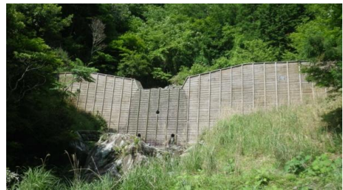
木材(間伐材)を利用した治山ダム工
