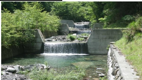
汗見川上流の治山工事
