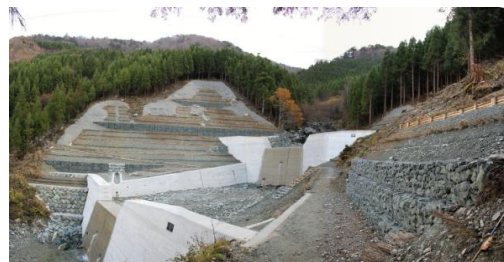
アシ谷地区の治山工事
