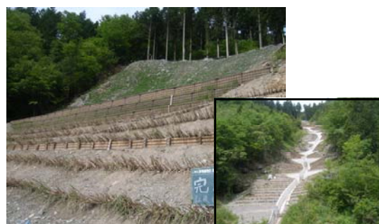
山腹崩壊地に施工した丸太筋工 (高知県いの町)
