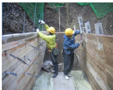
上下流側に施工している木製型枠工 (高知県馬路村)
