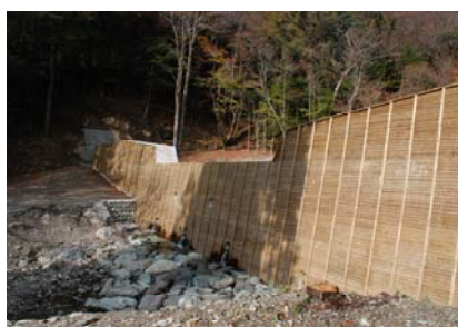
存置型型枠を使用した治山ダム工 (高知県いの町)
