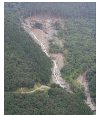
西山地区の地すべり被害状況
