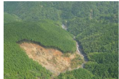
馬路村内の台風被害状況
