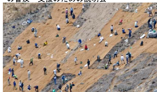
ボランティアとの協働による土砂流出防止のためのマット敷設(高知県香美市カヤハゲ)
