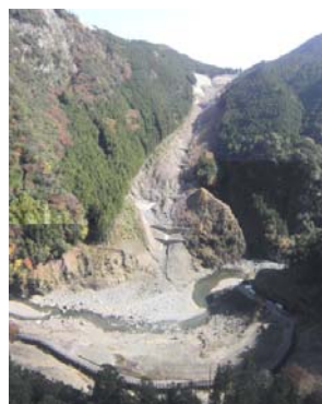
阿津江地区の施工状況
