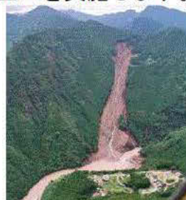
阿津江地区の崩壊地全景
