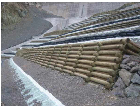
木製枠に栗石を充填した土留工（徳島県那賀町）
