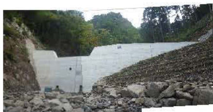
国有林内の谷止工施工状況
