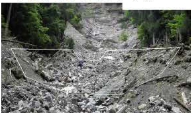
国有林内の溪流荒廃状況
