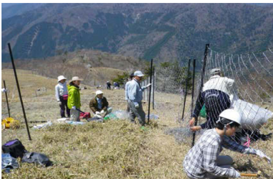
ボランティアとの協働による防護ネット柵の設置(高知県香美市白髪山)
