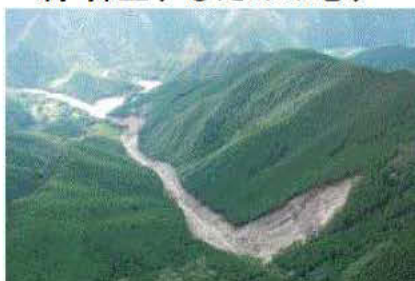
奈半利川地区の崩壊地全景
