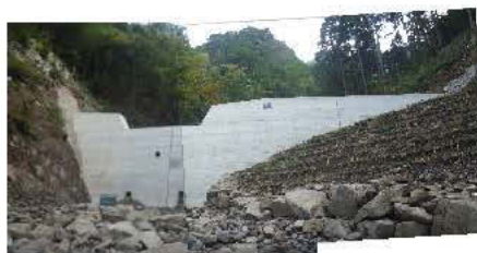
国有林内の谷止工施工状況
