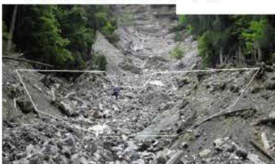
国有林内の溪流荒廃状況
