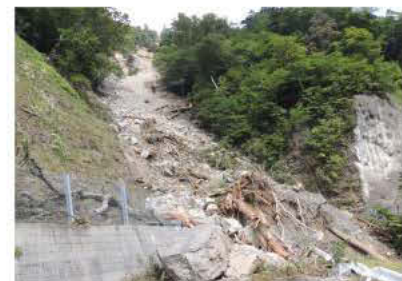
穴吹川(見ノ越中)地区の崩壊全景
