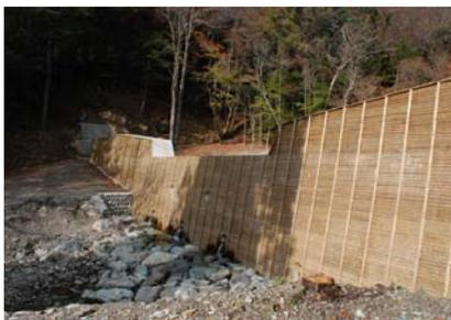
存置型型枠を使用した治山ダム工
