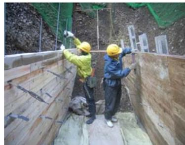
上下流側に施工している木製型枠工
