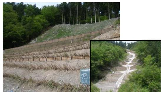
山腹崩壊地に施工した丸太筋工
