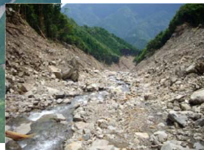
平鍋地区の溪流荒廃状況
