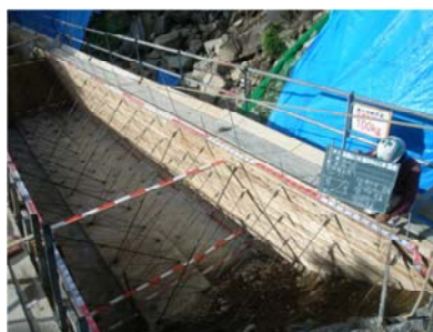
木製型枠組立状況（愛媛県久万高原町）
