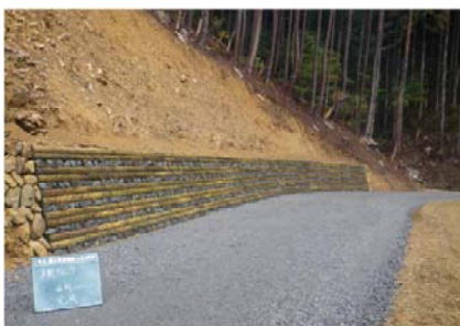
林道に施工した木製ブロック積工 (高知県三原村)
