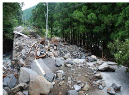
国道の被災状況
