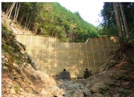
残存型枠を使用した谷止工 (高知県四万十町)
