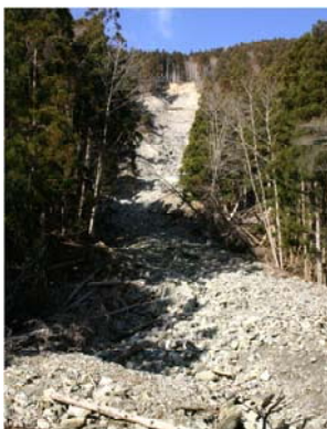
国有林内の荒廃状況
