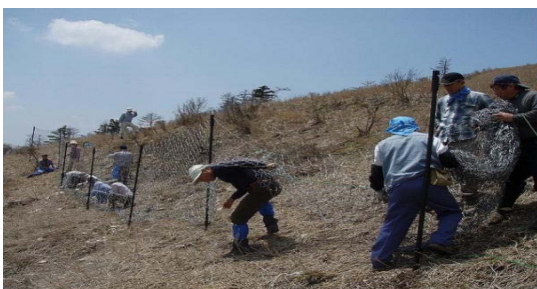
ボランティアとの協働による 防護ネット柵設置(三嶺)
