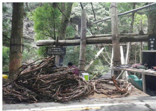
かずら橋架け替え資材の供給
