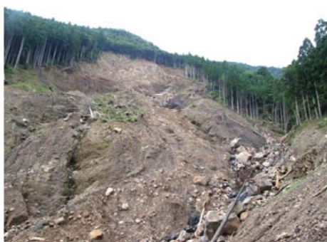
大谷地区の崩壊上部の状況
