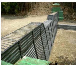
谷止工の施工状況
