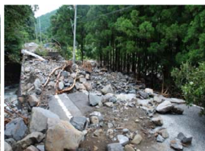
国道の被災状況
