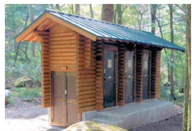
〔愛媛県 面河四国カルスト自然休養林〕 (面河地区のバイオトイレ)
