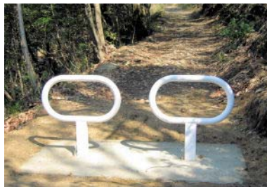
〔香川県 飯の山風景林〕 (車止め補修)
