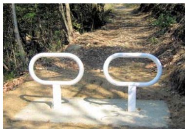
〔香川県 飯の山風景林〕 (車止め補修)
