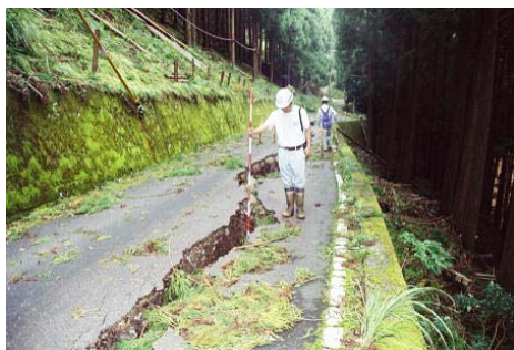
(町道路肩欠壊状況)
