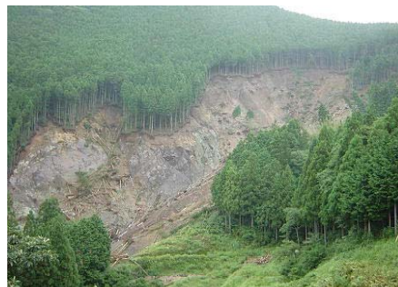
(崩壊地中腹状況)
