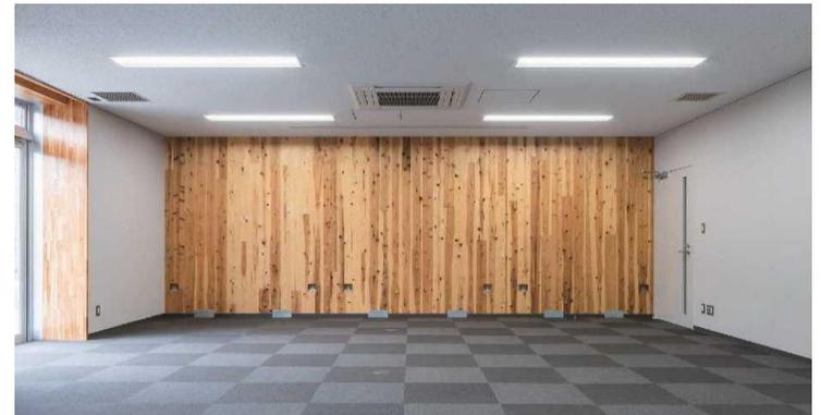
※CLTとは、直交集成材の(Cross Laminated Timber)略で、ひき板(ラミナ)を繊維方向が直交するよう積層接着した重厚なパネル
