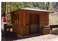
千本山風景林登山口 （改修後のトイレの様子）
