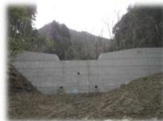
荒廃した溪流に設置された堰堤 (まんのう町 柞多尾国有林)
