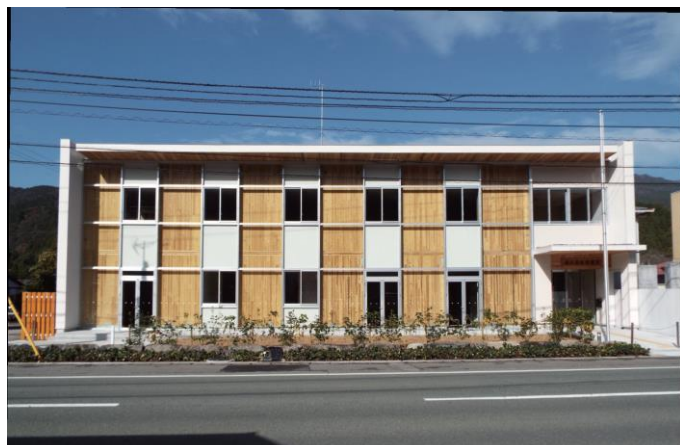
嶺北森林管理署 ～国で初めてのCLT庁舎～ (平成30年12月完成)
