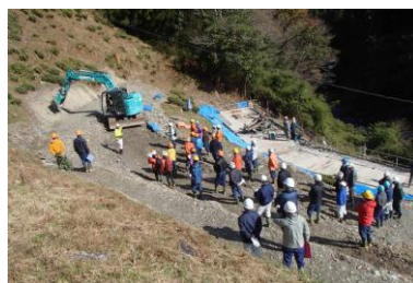
3次元起工測量説明 (R5年11月 祖谷川地区小川(下)地すべり防止工事)
