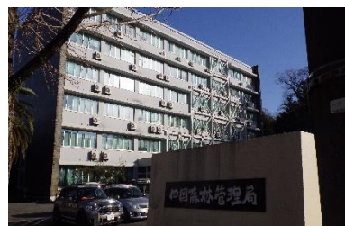
現・四国森林管理局庁舎
