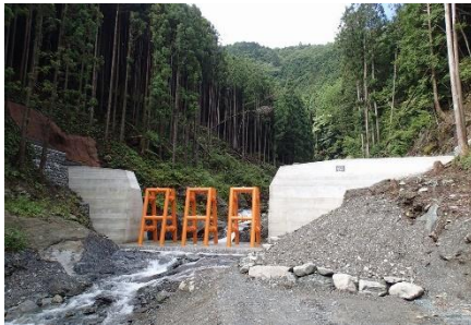
民有林直轄治山事業（仁尾ヶ内地区） （高知県大豊町） ※令和3年度から事業着手
