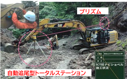
ICT掘削実行中 （栃谷山復旧治山工事）高知県北川村：安芸署
