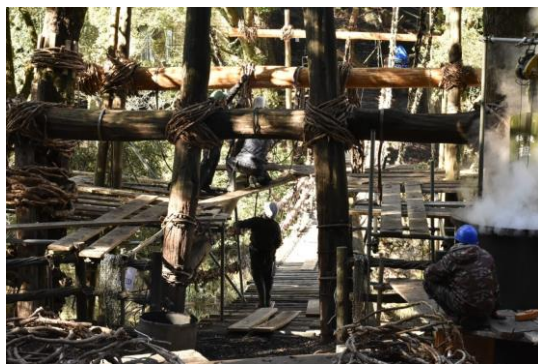
祖谷のかずら橋・架替作業中
