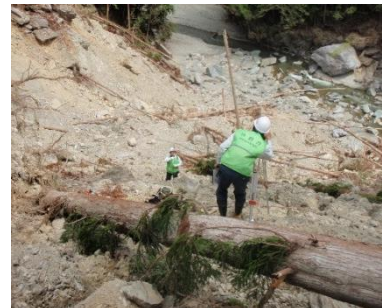
測量作業の様子(高知県大豊町)
