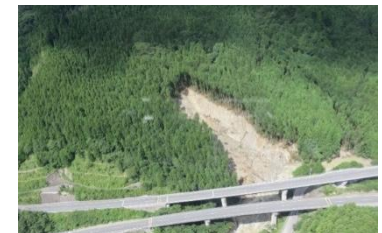
大豊町立川上名の被災現場
