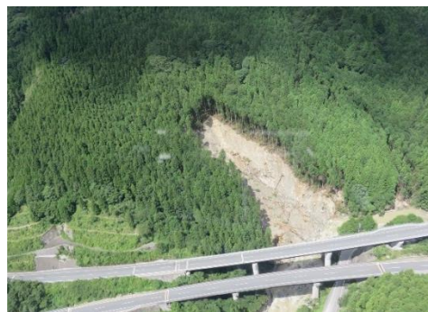
大豊町立川上名の被災現場
