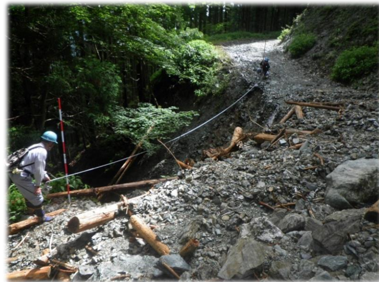
防災ボランティアと連携した迅速な被害状況の把握 (徳島県三好市の被災現場)
