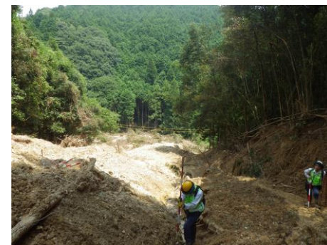
測量作業の様子
