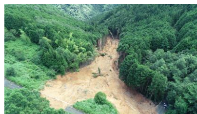
大洲市河辺町の被災現場
