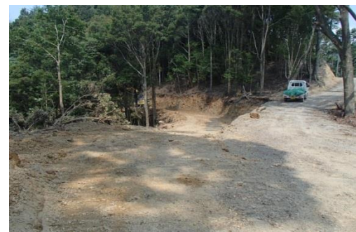
高知県宿毛市還住敷の迂回路として整備した森林作業道（左：民有林。右：国有林）
