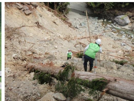
測量作業の様子
