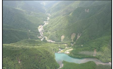
A徳島県三好市(名頃ダム)
