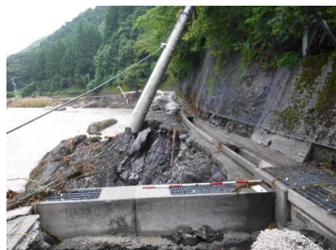
高知県安芸市の県道の被害状況
