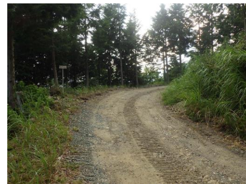
高知県大豊町仁尾ヶ内地区の迂回路として整備した国有林林道
