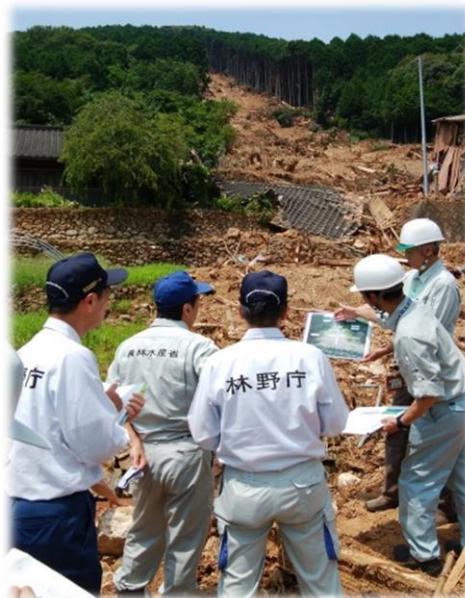
齋藤農林水産大臣の視察 (愛媛県西予市宇和町の林地崩壊現場)
