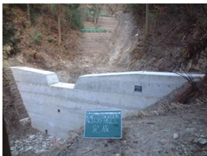
【現地に施工された治山えん堤】
