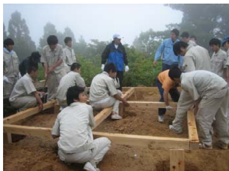
【建設中の様子】
