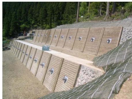
【残存型枠を使用したアンカー工受圧板】
