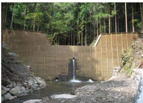
【残存型枠を使用した谷止工】
