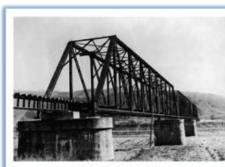
8月 奈半利川橋
