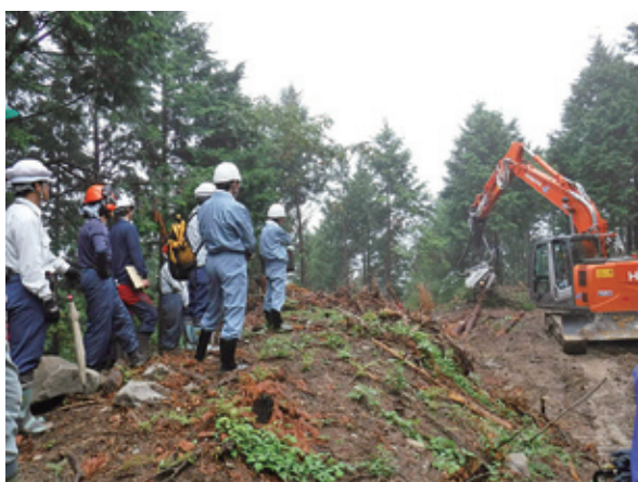
造材作業について点検
