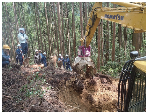
作業道作設の様子
