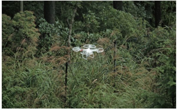
ネット点検の様子
